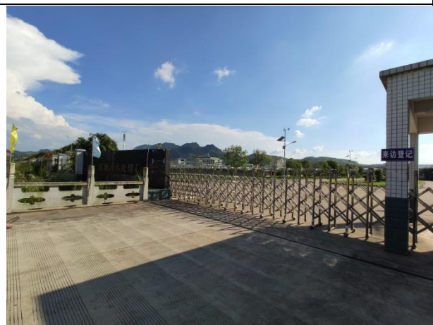
园区污水处理厂（官塘污水处理厂）
