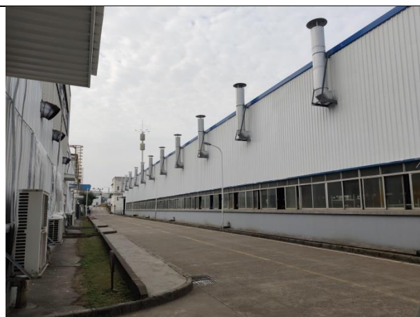
旧厂区焊装车间
