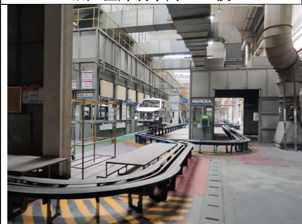
旧厂区涂装车间
