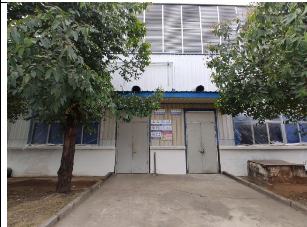
旧厂区涂装车间油漆库房
